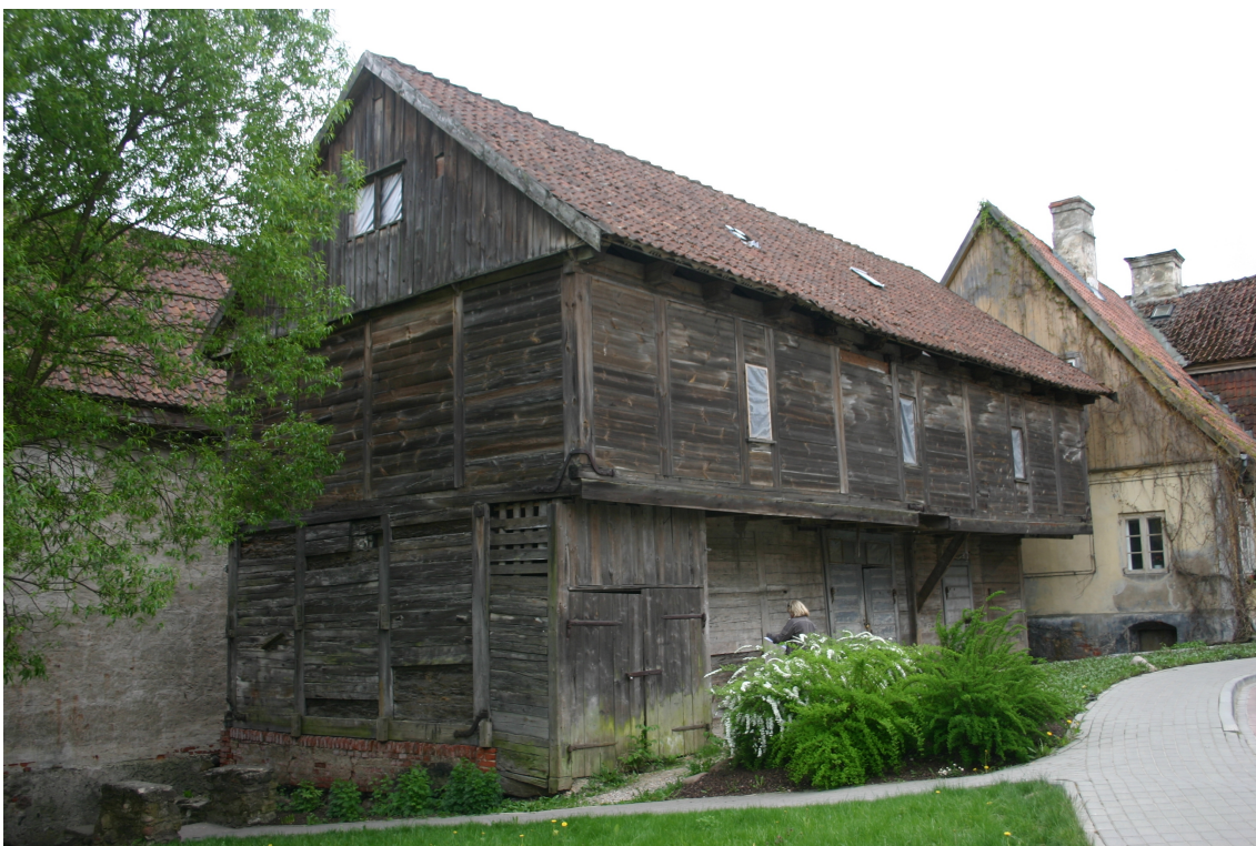
Bazniicas_7a_62010060108001_fasade2 Skats uz ēku no ziemeļiem.
