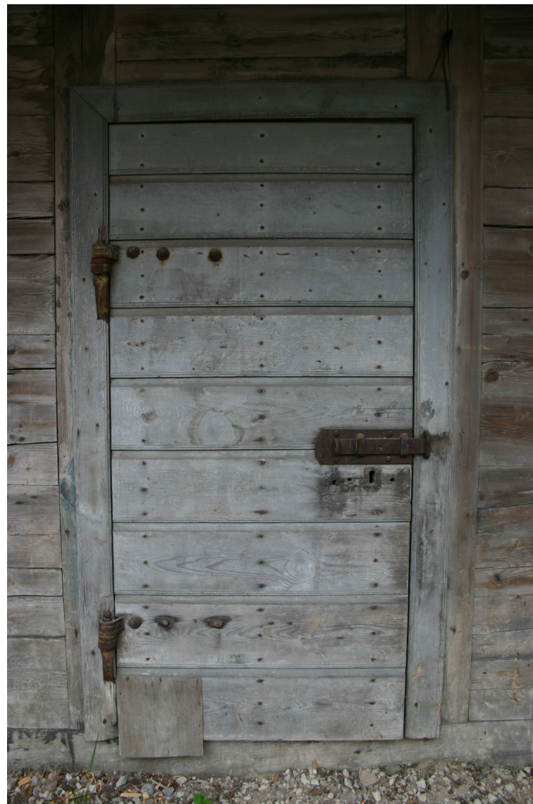
Bazniņas_7a_62010060108001_durvis1 Sākotnējās (19.gs.3.cet.) durvis ar oriģinālo aprīkojumu un apmalēm.
