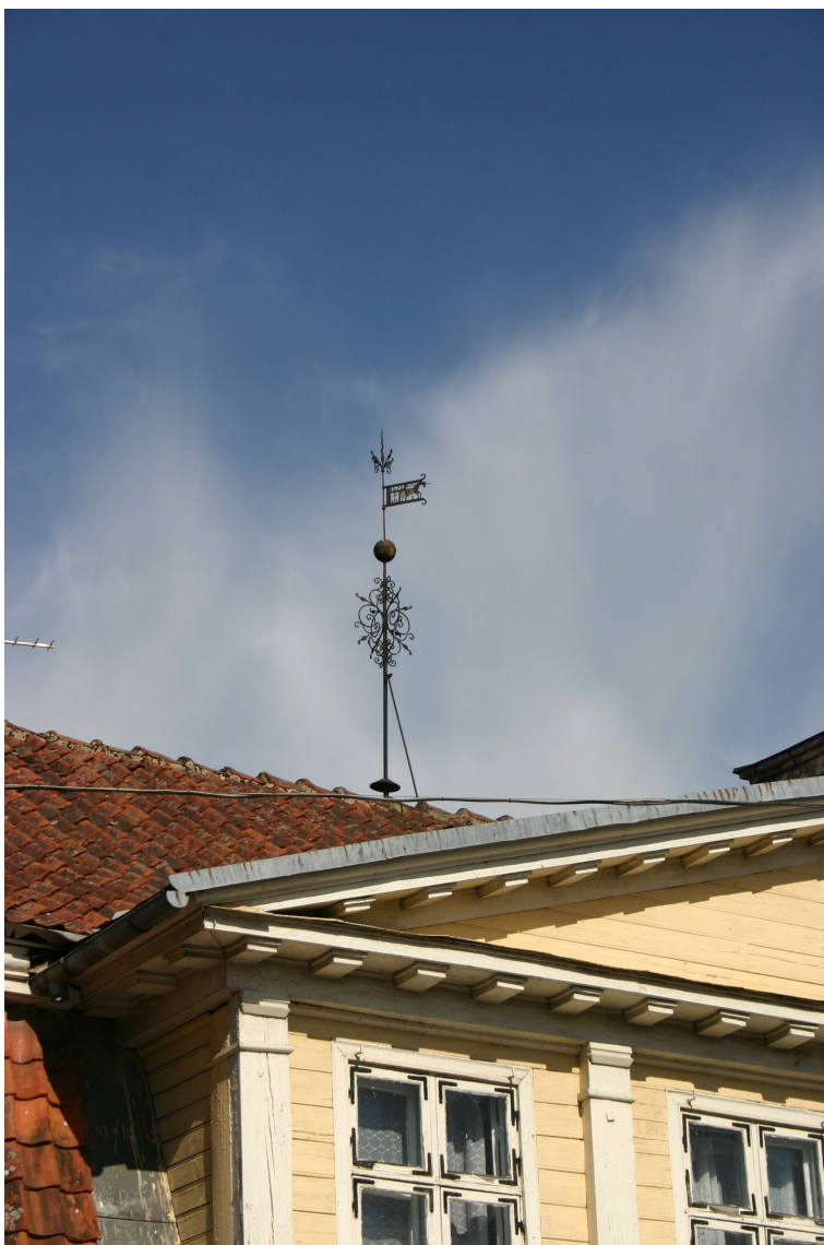
Bazniicas_7_62010060057001_fragments1 Galvenās fasādes fragments ar 19.gs.1.cet. izveidoto mezonīnu un 20.gs.2.pusē izgatavoto vējrādītāja kopiju.
