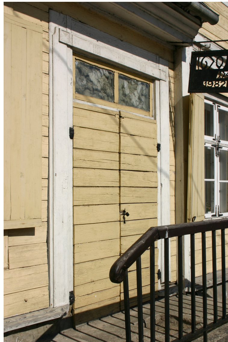
Baznīcas_7_62010060057001_durvis2 19.gs.3.cet. durvju komplekts.
