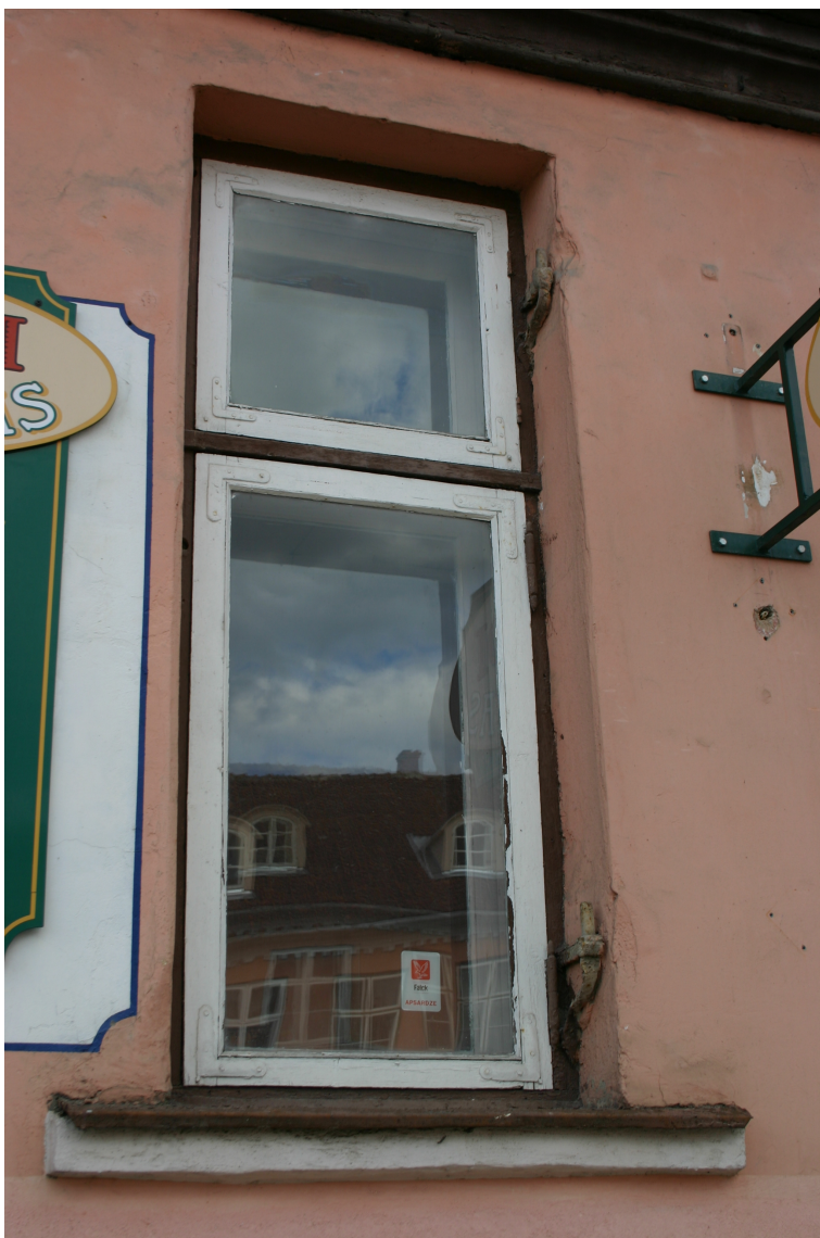
Bazniicas_6_62010230014001_logs2 19.gs.3.cet. loga aploda un slēgu viru kāši, vērtnes – 20.gs.2.puse.
