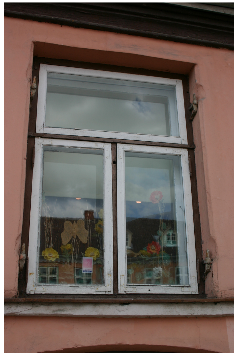
Bazniīcas_6_62010230014001_logs1 19.gs.3.cet. loga aploda un slēgu viru kāši, vērtnes – 20.gs.2.puse.
