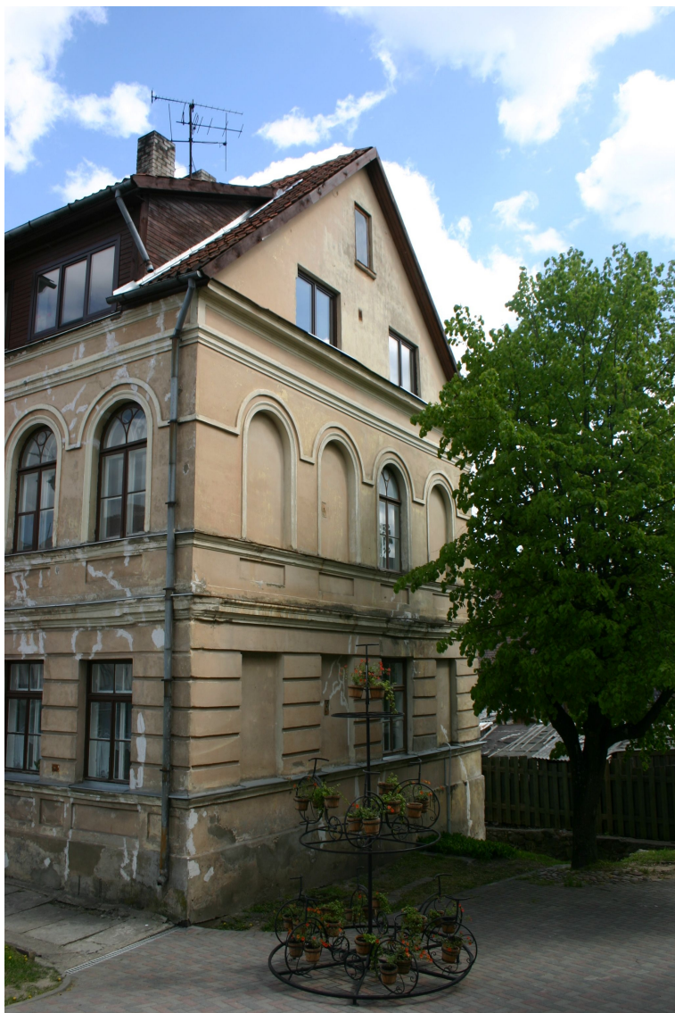
Bazniicas_3_62010060041001_fasade2 Skats uz ēkas dienvidrietumu fasādi.
