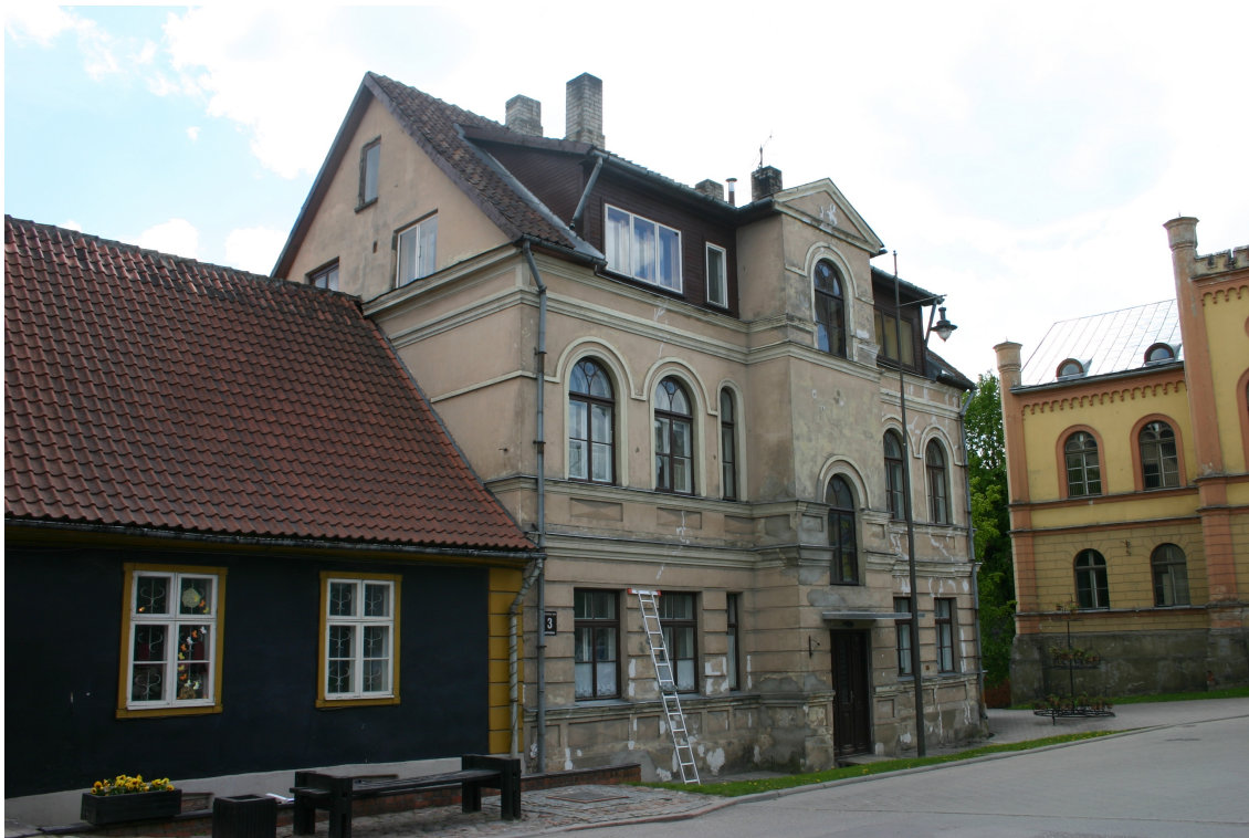
Bazniicas_3_62010060041001_fasade1 Skats uz ēku no ziemeļiem.
