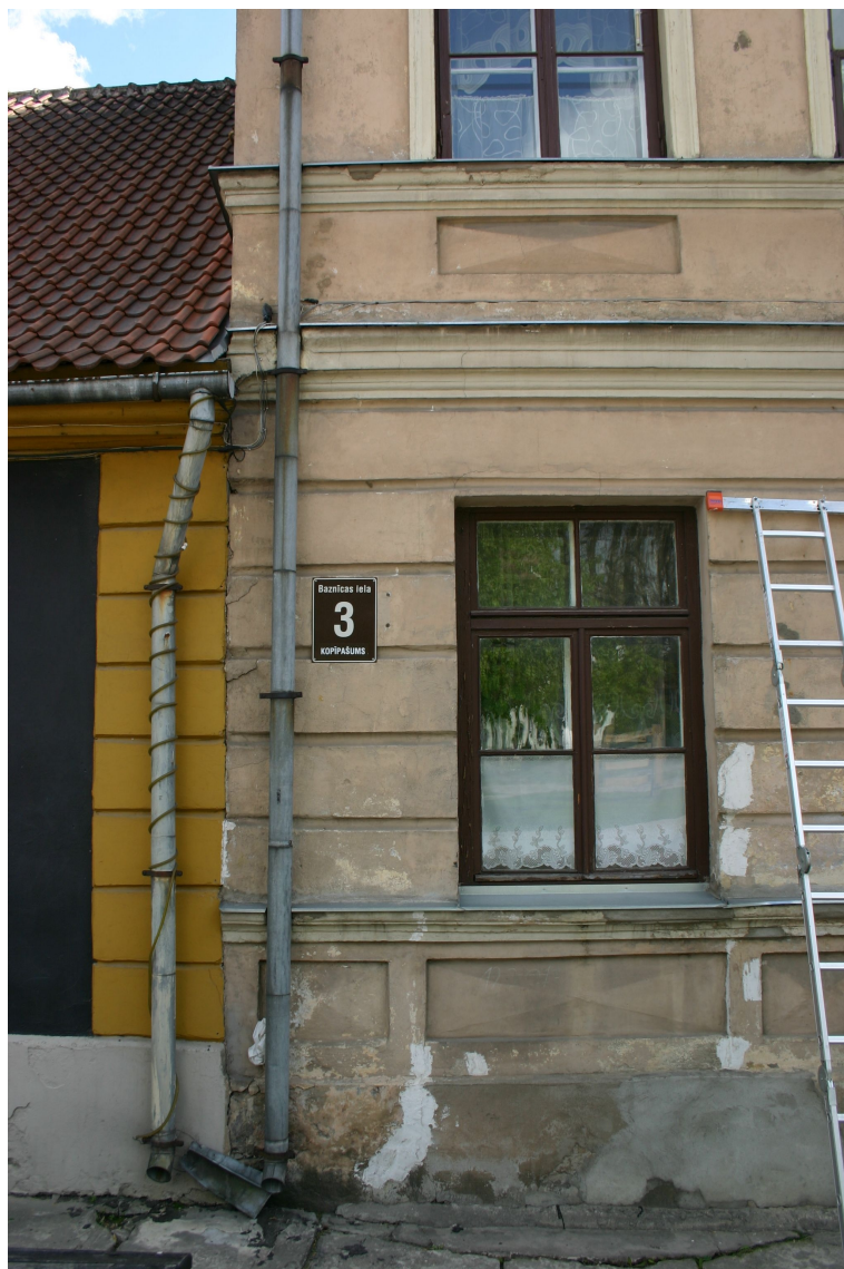
Baznīcas_3_62010060041001_fragments1 Galvenās fasādes fragments ar sākotnējo (19.gs.3.cet.) dekoratīvo apdari.
