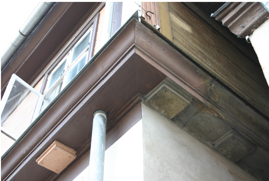
Bazniicas_2_4_62010230007001_0006001_dzega1 Vēsturiska (19.gs.sāk.) dēļu starpdzega.
