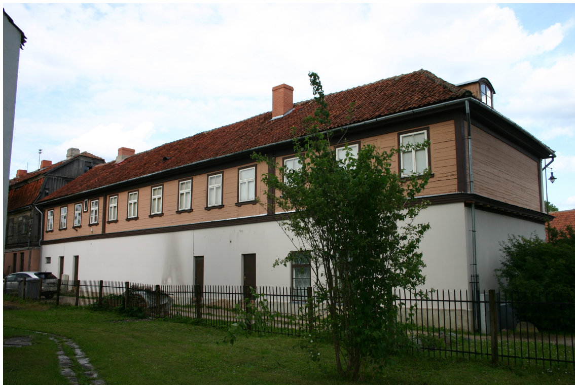
Bazniīcas_2_4_62010230007001_0006001_fasade2 Skats uz ēku no dienvidrietumiem.
