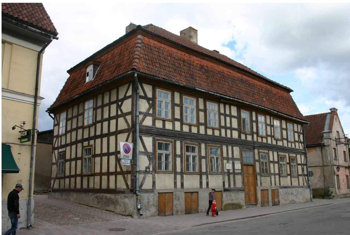
Bazniīcas_10_62010060061001_fasade1 Skats uz ēku no dienvidaustrumiem.
