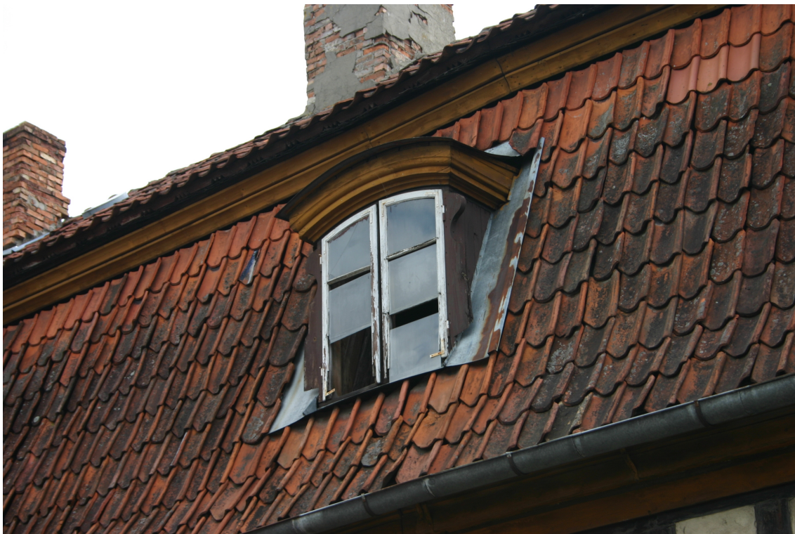
Baznīcas_10_62010060061001_fragments1 1986.gada jumta izbūve, kas veidota pēc vēsturiskās parauga.
