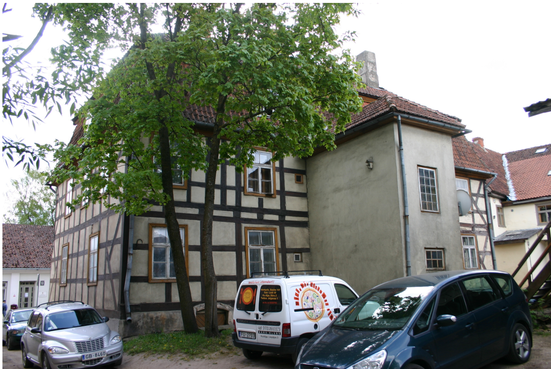
Bazniicas_10_62010060061001_fasade3 Skats uz ēku no ziemeļrietumiem. Piebūve uzcelta 1986.gadā.
