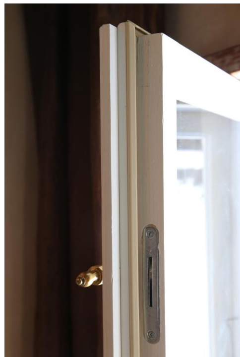
8 un 9. att. Atjaunojamais logs ar tajā iestrādātajiem brīvēšanas risinājumiem – blīvgumijām un ķītiņu stiklu ārējās vērtnēs. 13
