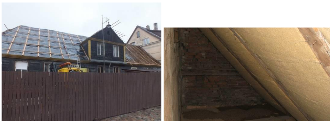
26. att. Uz jumta difūzijas plēve - zem seguma - māla kārņiņiem. 27. att. Jumta plaknes siltinājums ar kokšķiedras plāksnēm.
