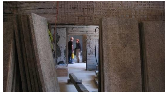
20. un 21. att. Pārbūves laikā. Atsegtās aukstās pažobeles un to konstrukcija. Un demontētie 1973.g. atjaunošanā izmantotie materiāli, t.sk. fibrolīta loksnes.
