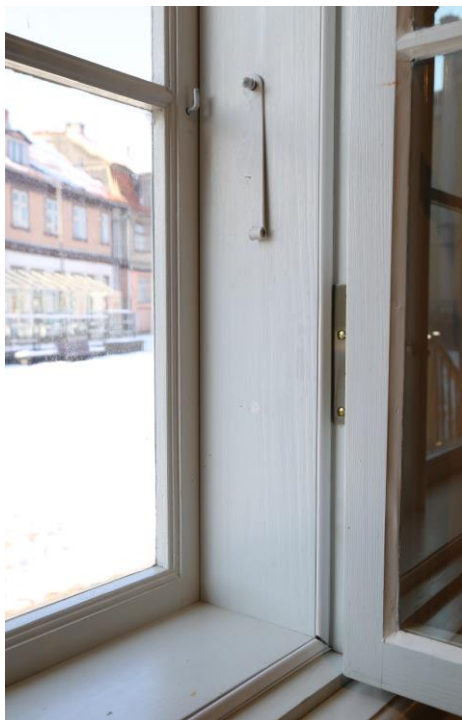
8 un 9. att. Atjaunojamais logs ar tajā iestrādātajiem brīvēšanas risinājumiem – blīvgumijām un ķītiņu stiklu ārējās vērtnēs. 13
