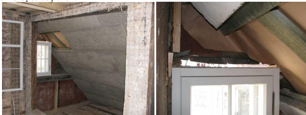
28. un 29. att. Virs kokšķiedras plāksnēm ierīkota tvaika barjera, latas un fibrolīta slānis, pēc tam izveidots kaļķu javas apmetuma slānis.
