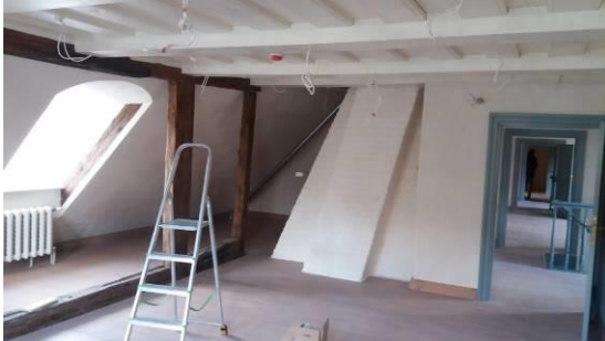
22. att. Pēc pārbūves. Aukstās pažobeles pievienotas apkurināmai un izmantotai telpai.
