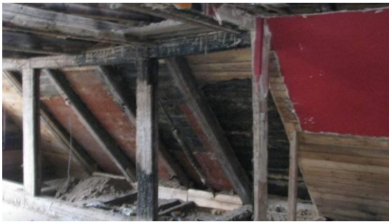
20. un 21. att. Pārbūves laikā. Atsegtās aukstās pažobeles un to konstrukcija. Un demontētie 1973.g. atjaunošanā izmantotie materiāli, t.sk. fibrolīta loksnes.
