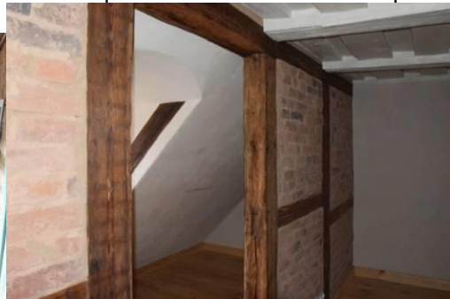
23. un 24. att. Pēc pārbūves. Daļēji pievienotas aukstās pažobeles apkurināmai telpai - ar atvērumiem pildrežģu sienās, lai nodrošinātu izgaismošanu no izveidotajām jumta izbūvēm.
