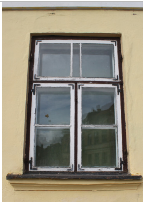
Logs galvenajā fasādē
