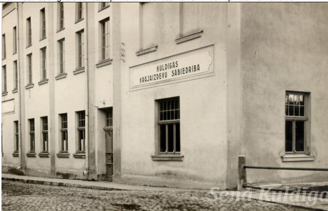
Krājaizdevu sabiedrības telpas ēkas Z stūrī. 1930-tie
