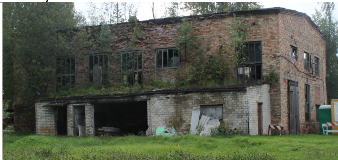
Skats uz ēkas ZA fasādi
