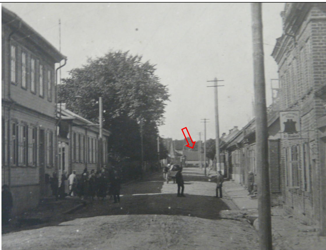
Skats uz ēku talā Jelgavas ielas perspektīvā (kreisajā pusē – f-ka „Vulkāns”). 1920-tie
