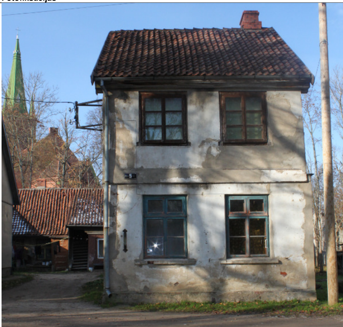
Ēkas galvenā fasāde
