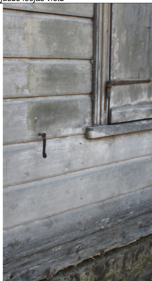
Fasādes fragments ar slēgi un fiksatoru
