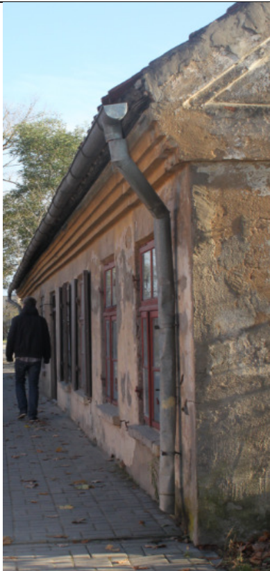
ZR stūra fragments (ietves paaugstināšanas dēļ logu palodzes gājējam atrodas ceļu augstumā)
