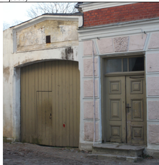
Rumbas ielas fasādes fragments – sākotnējo durvju komplekts ar oriģinālo aprīkojumu un vārtu arku
