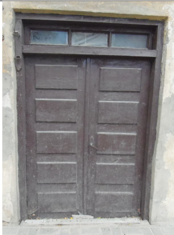
Galvenās ieejas durvis. sliekšnis nav redzams, jo atrodas zem ietves līmeņa
