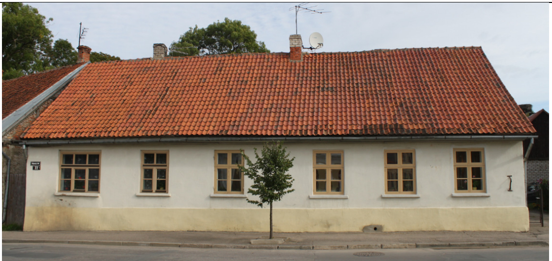
Ēkas galvenā fasāde
