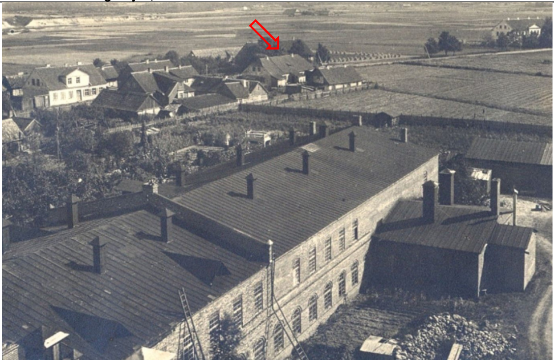
Skats no sērskociņu f-kas „Vulkāns” skursteņa. 1920-tie
