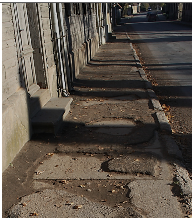
Ietves fragments pie ieejas – zem nodrupušā asfalta redzamas vēsturiskās betona plātnes
