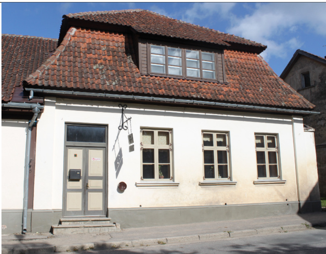
Austrumu spārna fasāde ar galveno ieeju
