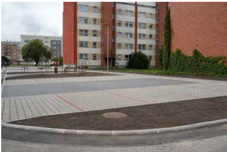
Gaismas ielā 9, Kuldīgā izbūvēts jauns stāvlaukums, kurā var novietot 35 auto, viena stāvvietā paredzēta invalīdiem.
