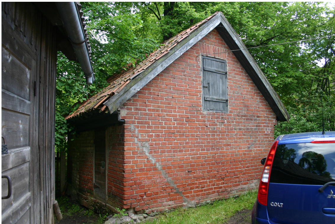
Baznīcas_1_62010230029004_fasade1 Skats uz ēku no ziemeļaustrumiem.
