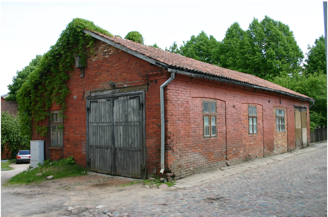
Baznīcas_1_62010230029002_fasade2 Skats uz ēku no ziemeļrietumiem.
