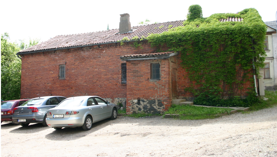
Bazniicas_1_62010230029002_fasade3 Skats uz ēku no austrumiem. Piebūve uzcelta 20.gs.1.cet. (pēc 1913.g.).
