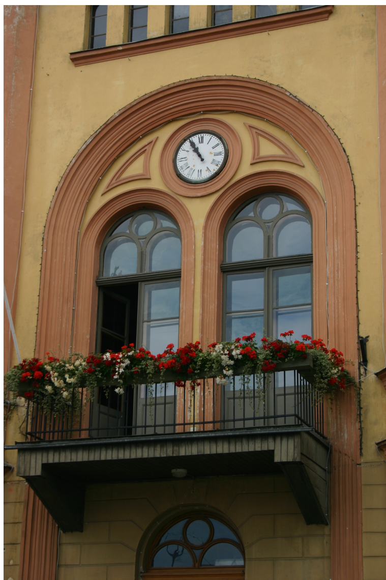
Bazniicas_1_62010230029001_fragments1 Galvenās fasādes fragments ar sākotnējo (1860.-1868.g.) dekoratīvo apdari, balkona durvīm un 20.gs.2.pusē remontētu (margas, apšuvums) balkonu.
