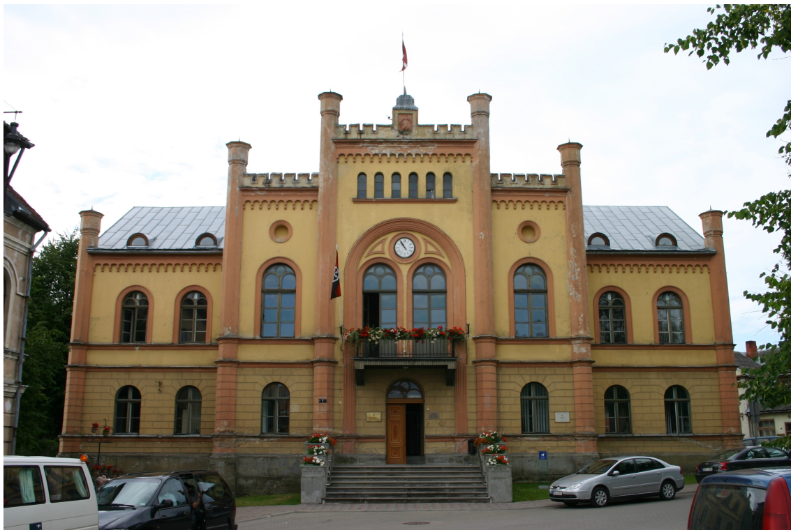
Baznīcas_1_62010230029001_fasade1 Ēkas ziemeļu fasādes kopskats.
