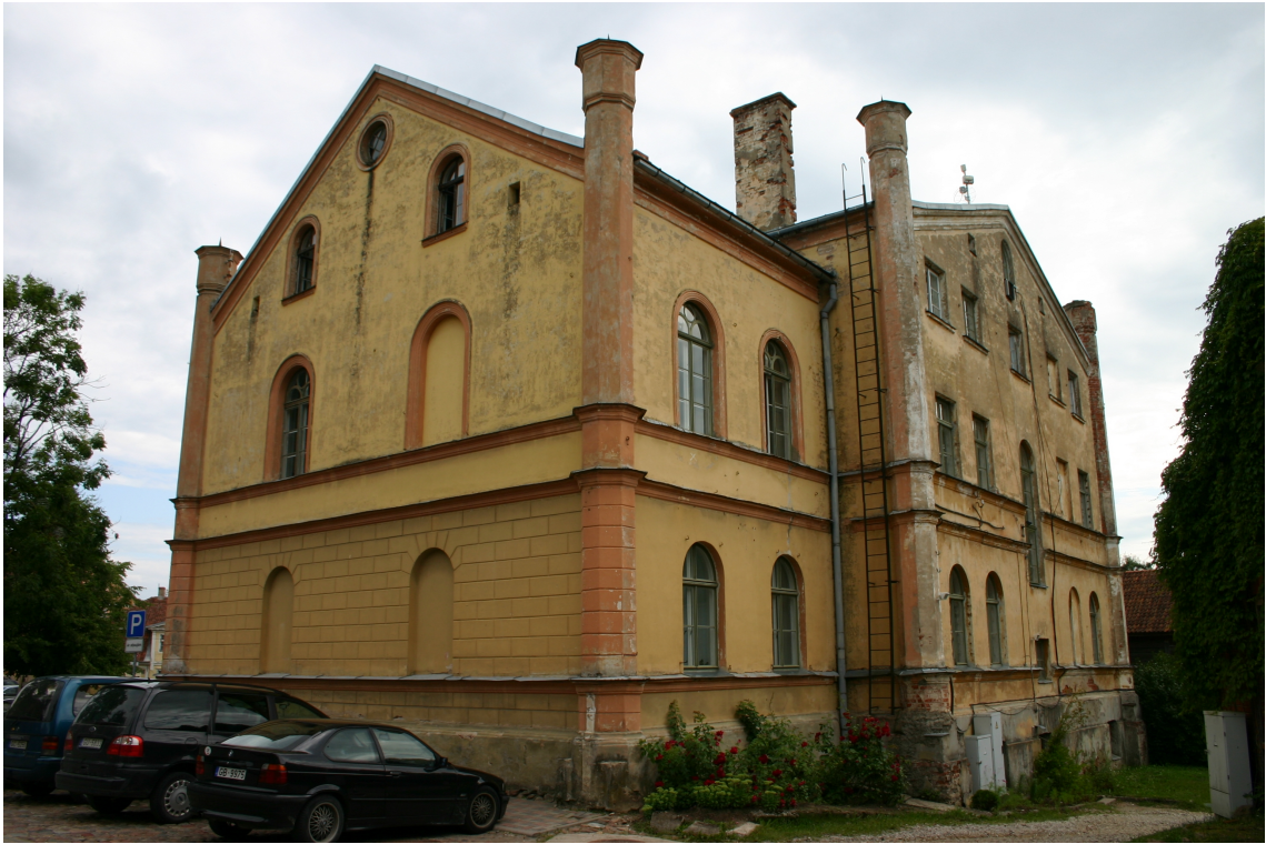
Bazniīcas_1_62010230029001_fasade3 Skats uz ēku no dienvidrietumiem.
