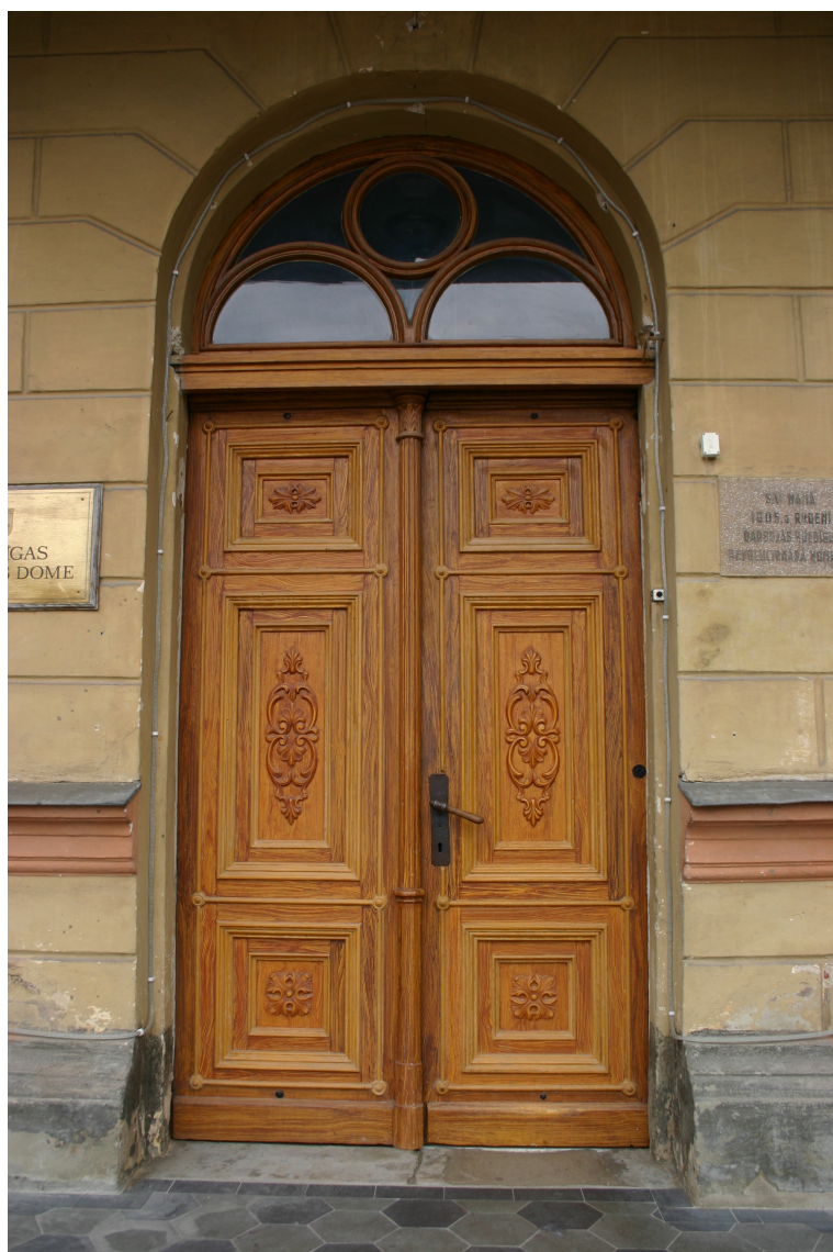
Baznīcas_1_62010230029001_durvis1 Sākotnējo (1860.-1868.g.) durvju komplekts ar oriģinālo aprīkojumu.
