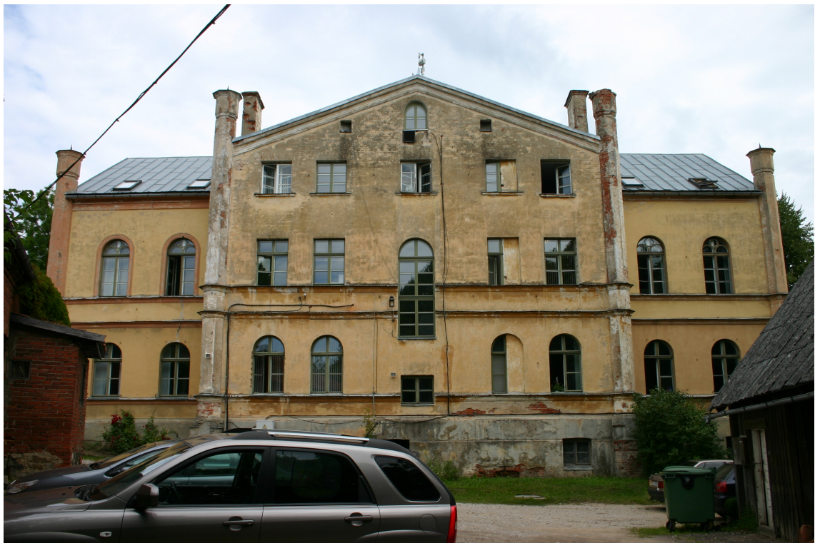
Bazniīcas_1_62010230029001_fasade4 Ēkas dienvidu fasādes kopskats.
