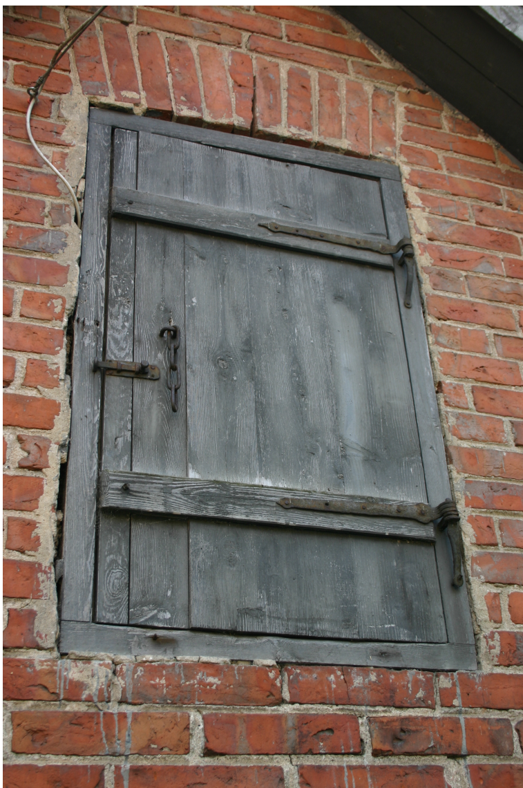
Bazniicas_1_62010230029004_durvis1 Sākotnējās (20.gs.1.cet., pēc 1913.g.) durvis ar oriģinālo aprīkojumu.
