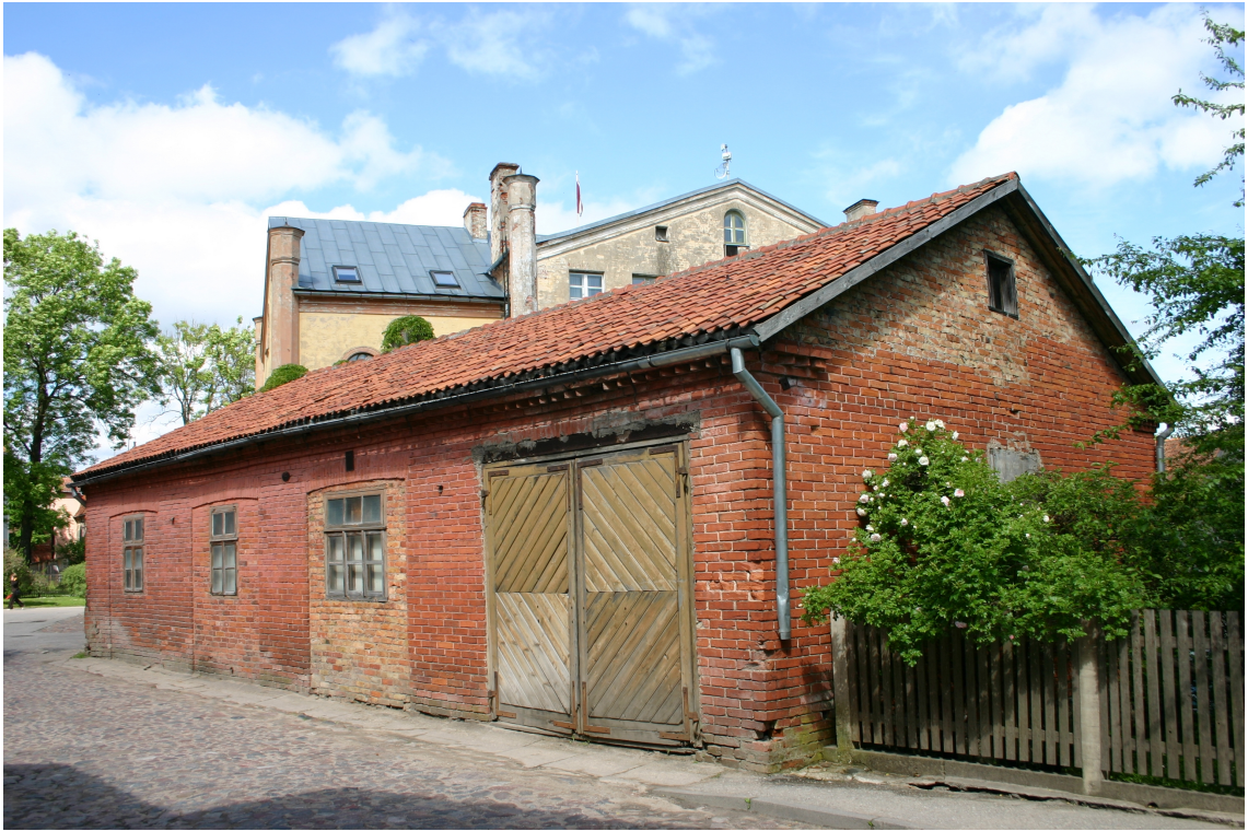
Baznīcas_1_62010230029002_fasade1 Skats uz ēku no dienvidrietumiem.
