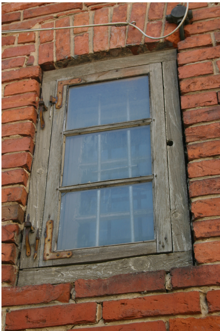
Bazniicas_1_62010230029002_logs1 Sākotnējs (19.gs.3.cet.) logs ar oriģinālo aprīkojumu.
