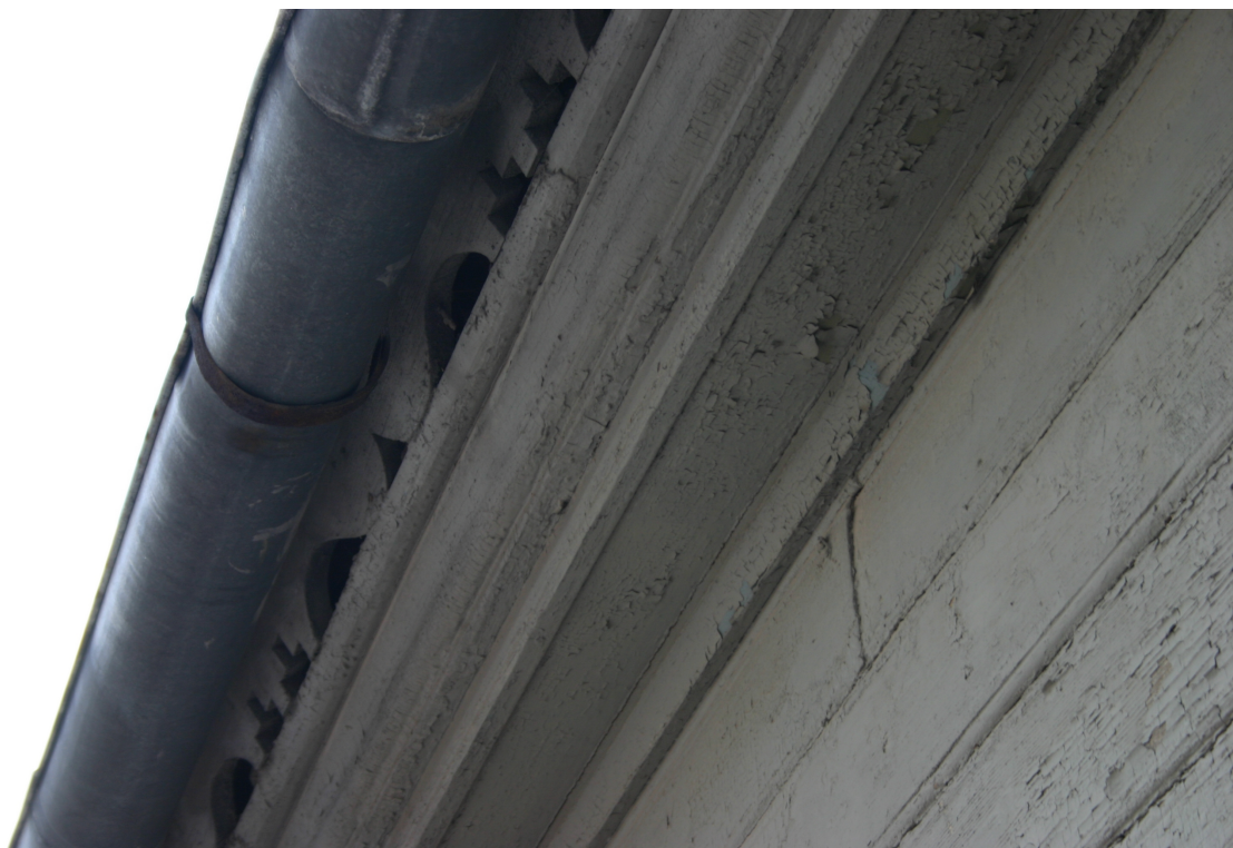
1905_gada_1_62010060039001_dzega1 Vēsturiska dēļu dzega un kokā griezts aizsegdēlis.
