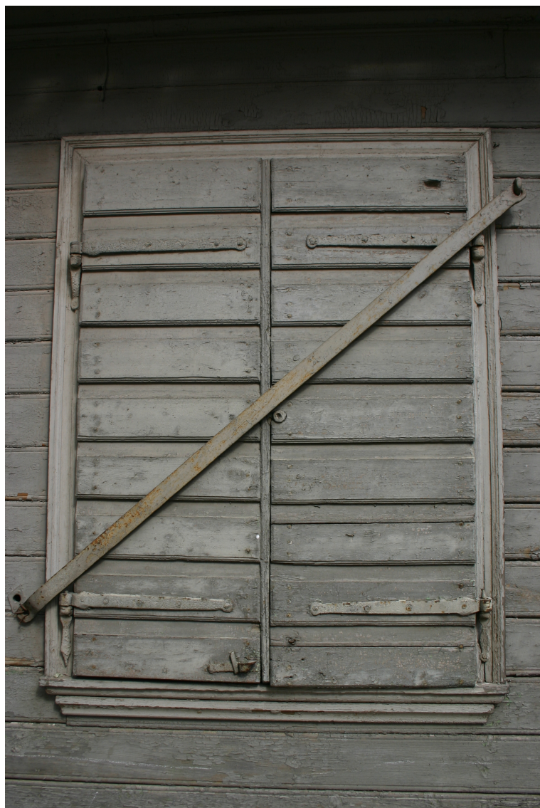
1905_gada_1_62010060039001_slegi1 Vēsturiski slēgi ar oriģinālo aprīkojumu.
