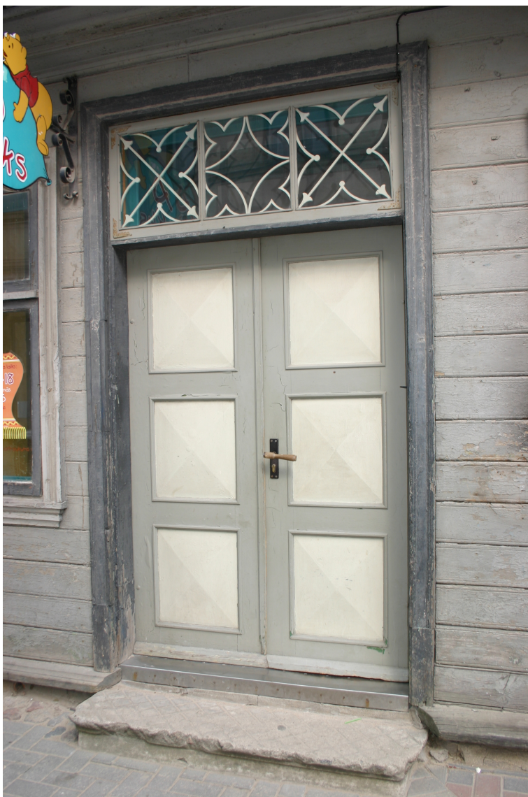
1905_gada_1_62010060039001_durvis1 Vēsturisku durvju komplekts. Virslogs - 20.gs.2.puse, izmantojot vēsturiskās detaļas.
