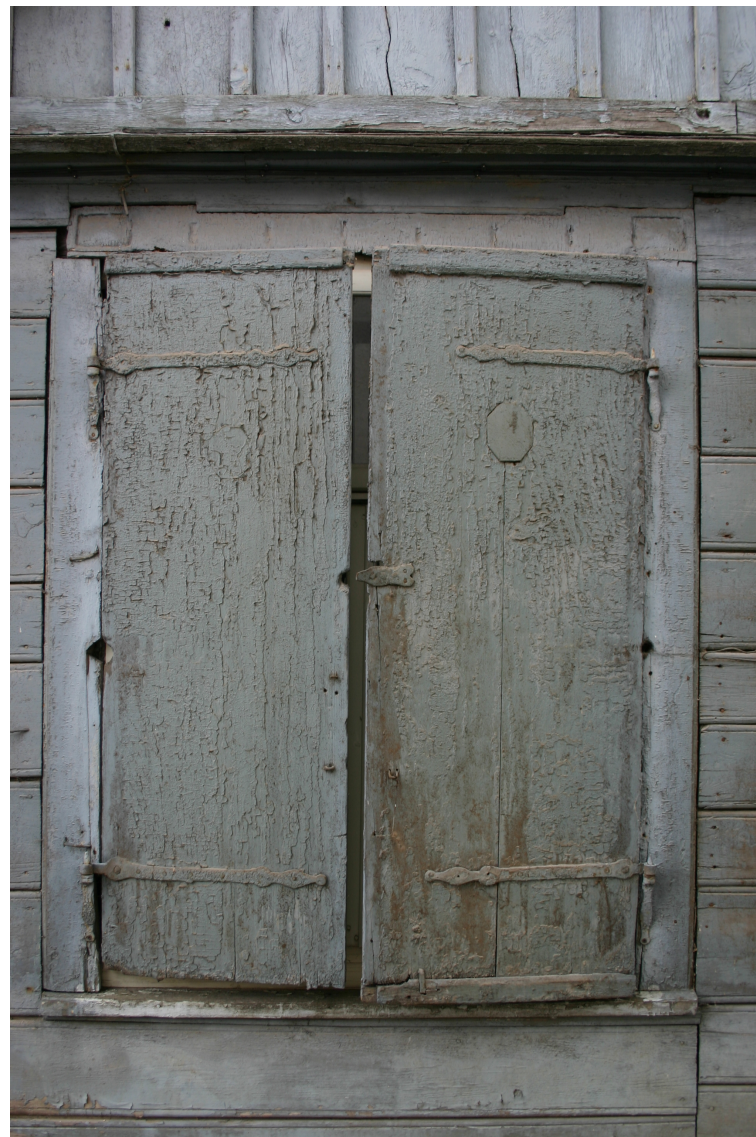
1905_gada_1_62010060039001_slegi3 Vēsturiski slēgi ar oriģinālo aprīkojumu.
