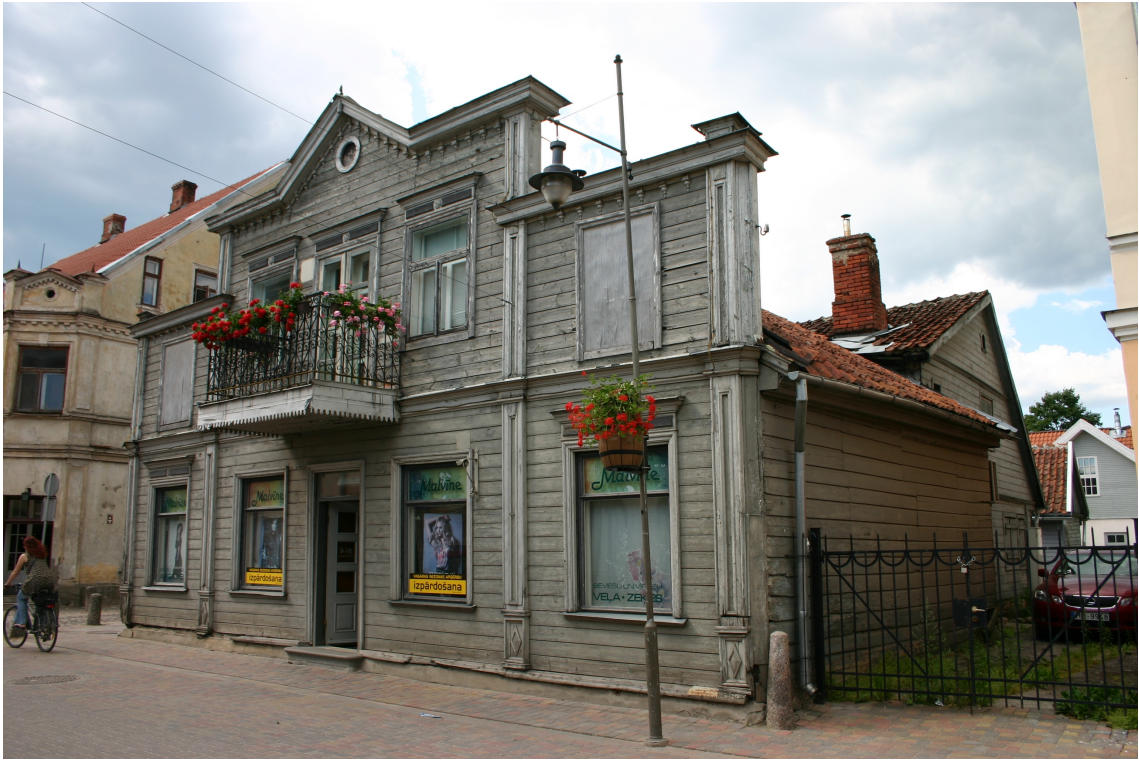
1905_gada_1_62010060039001_fasade1 Skats uz ēku no dienvidaustrumiem.
