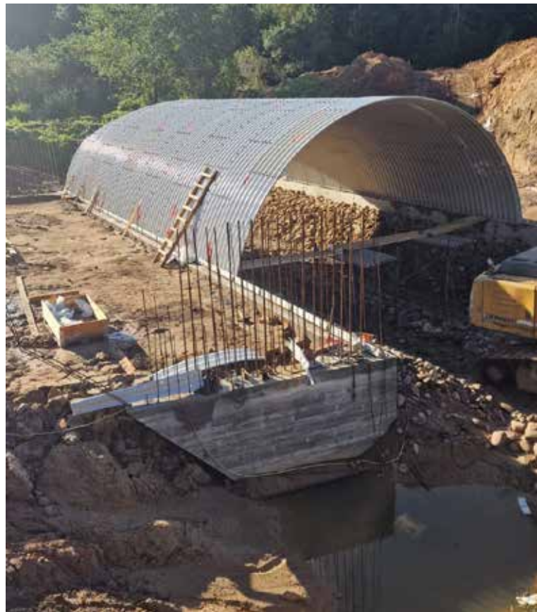
Augustā Riežupē veikta caurtekas arkas tērauda elementu montāža.
