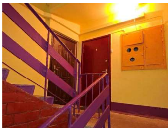
Kāpņu telpa pie vērtējamā objekta
