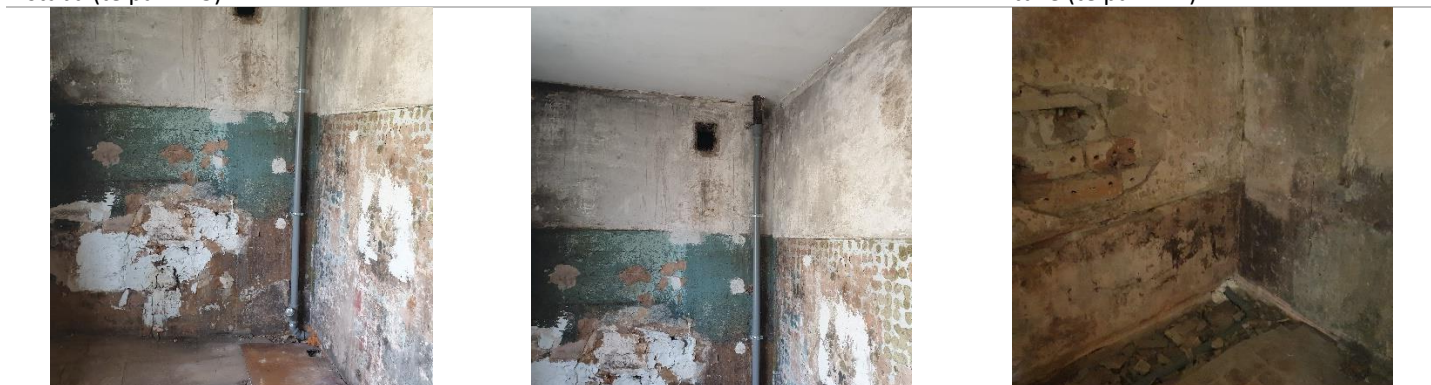
Sanitārā telpa (telpa Nr. 3)
