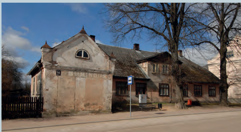
443. Veikalu ēkas Liepājas ielā 18 un Ventspils ielā 14 (J. Krastiņa foto. 2013) The shop buildings at Liepāja iela 18 and Ventspils iela 14 (Photo by J. Krastiņš. 2013)
