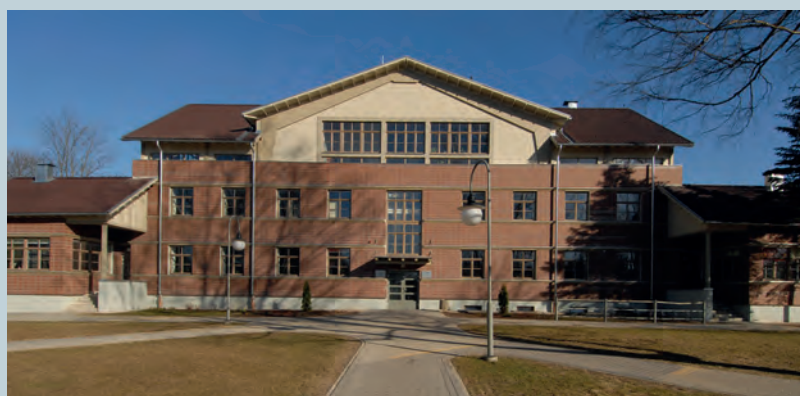
458. Skolas ēka Pēterā ielā 10. 20. gs. trīsdesmitie gadi. Pārbūve – 2011. “Ozola un Bula” (J. Krastiņa foto. 2013) The school at Pēterā iela 10. 1930’s. Reconstruction – 2011. “Ozola & Bula” (Photo by J. Krastiņš. 2013)
