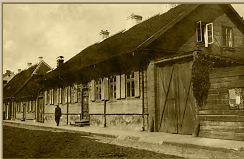
46. Ēka Liepājas ielā 17. Pa kreisi – nojauktās ēkas Liepājas ielā 19 un 21 (KNP BNDFA) Building at Liepājas iela 17. On the left – demolished buildings at Liepājas iela 19 and 21 (KDM CDDPA)
