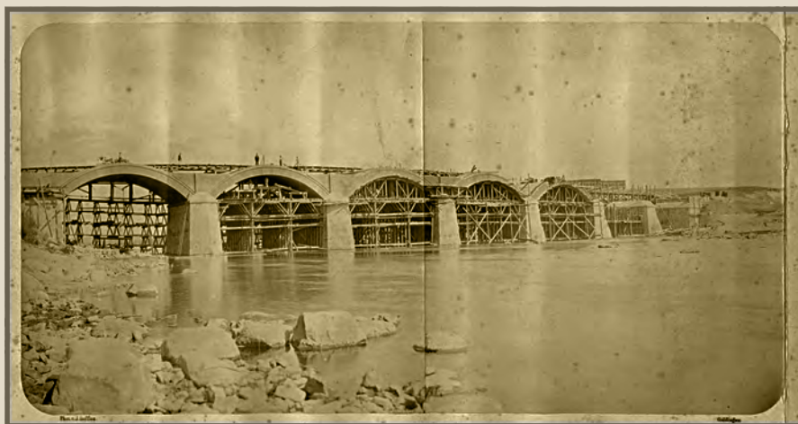
173. Mūra tilts pār Ventu Kuldīgā. Tilta būvniecība. I. Gessau fotogrāfija (LM, Berči būvprojektu arhīvs)
