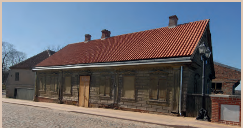
327. Dzīvojamā ēka Kalna ielā 24. 19. gs. otrā puse (J. Krastiņa foto. 2013) Residential building at Kalna iela 24. The second half of the 19th century (Photo by J. Krastiņš. 2013)
