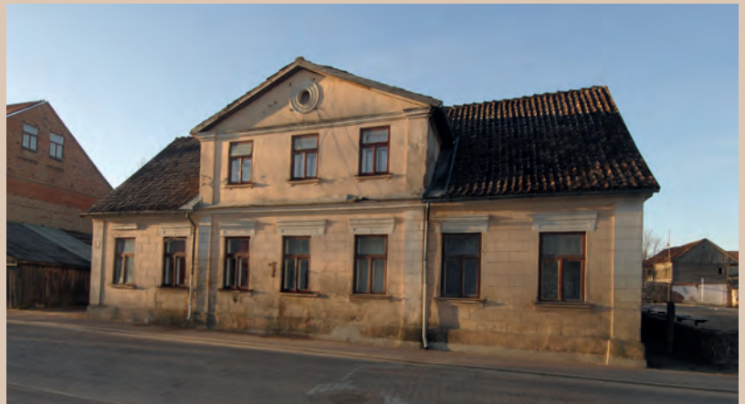
326. Dzīvojamā ēka Smilšu ielā 8. 19. gs. otrā puse (J. Krastiņa foto. 2013) Residential building at Smilšu iela 8. The second half of the 19th century (Photo by J. Krastiņš. 2013)
