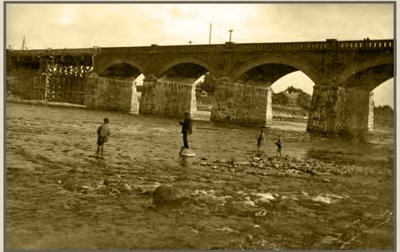
176. Mūra tilts pār Ventu Kuldīgā. Tilta pagaidu koka laidums ap 1923. gadu. (VKPAI PDC, Ventas tilta Kuldīgā uzņēmumu albums)
