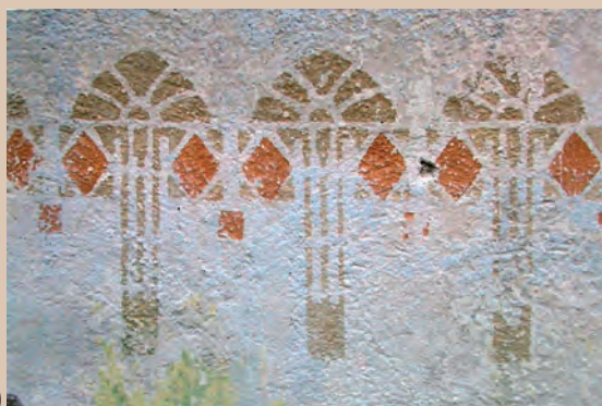
379. Sienas dekoratīvs krāsojums Baznīcas ielā 11. Ap 1910. gadu (A. Orniņa foto. 2002) Decorative paint work on the wall at Baznīcas iela 11. Approx. 1910 (Photo by A. Orniņš. 2002)
