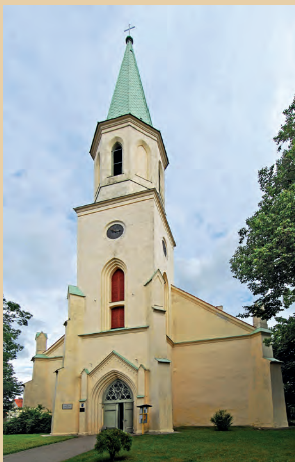
196. Svētās Katrīnas luterāņu baznīcas rietumu fasāde (J. Krastiņa foto. 2013)
