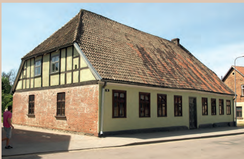
271. Dzīvojamā ēka Jelgavas ielā 15. 18. gs. otrā puse (Z. Bikšes foto. 2009) Residential building at Jelgavas iela 15. Second half of the 18th century (Photo by Z. Bikše. 2009)
