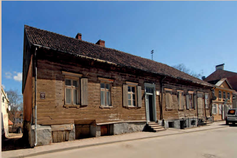
276. Dzīvojamā ēka Baznīcas ielā 17 (J. Krastiņa foto. 2013) Residential building at Baznīcas iela 17 (Photo by J. Krastiņš. 2013)
