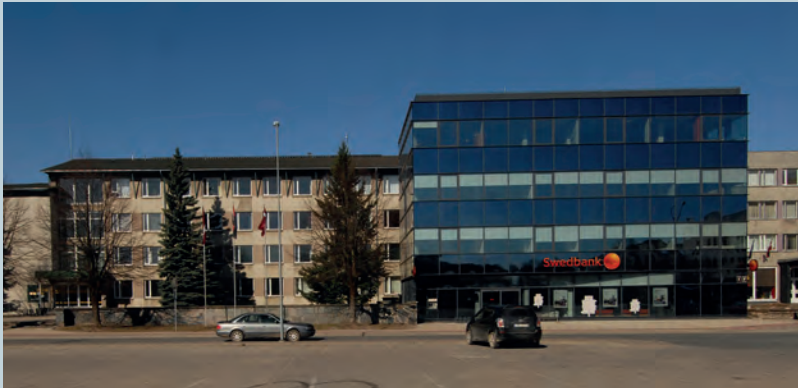
455. Padomju nama celtniecība Pilsētas laukumā 2 1967. gadā (KNM, Plg. 9220) un ēka mūsdienās (J. Krastiņa foto. 2013)
