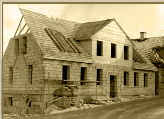
98. Kaļķu ielas 7 ēkas būvniecība septiņdesmitajos gados (KNP BNDFA) Construction of the building at Kaļķu iela 7 in the 1970's (KDM CDDPA)
