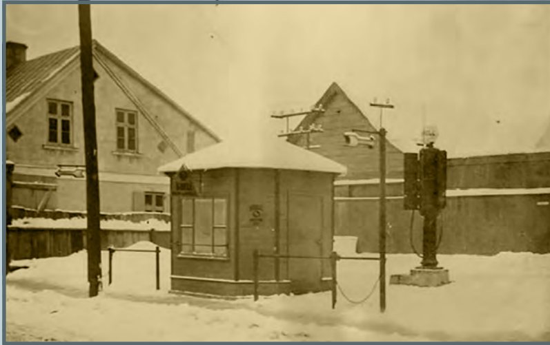
449. Benzīna uzpildes stacija Liepājas ielā 26 20. gs. trīsdesmitajos gados. (Publicitātes foto) The petrol filling station at Liepājas iela 26 in the 1930's. (Publicity photo)
