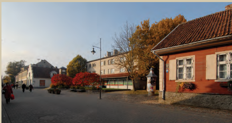
47. Ēka Liepājas ielā 19 1984. gadā (KNP BNDFA) un mūsdienās (J. Krastiņa foto. 2013) The building at Liepājas iela 19 in 1984 (KDM CDDPA) and nowadays (Photo by J. Krastiņš. 2013)
