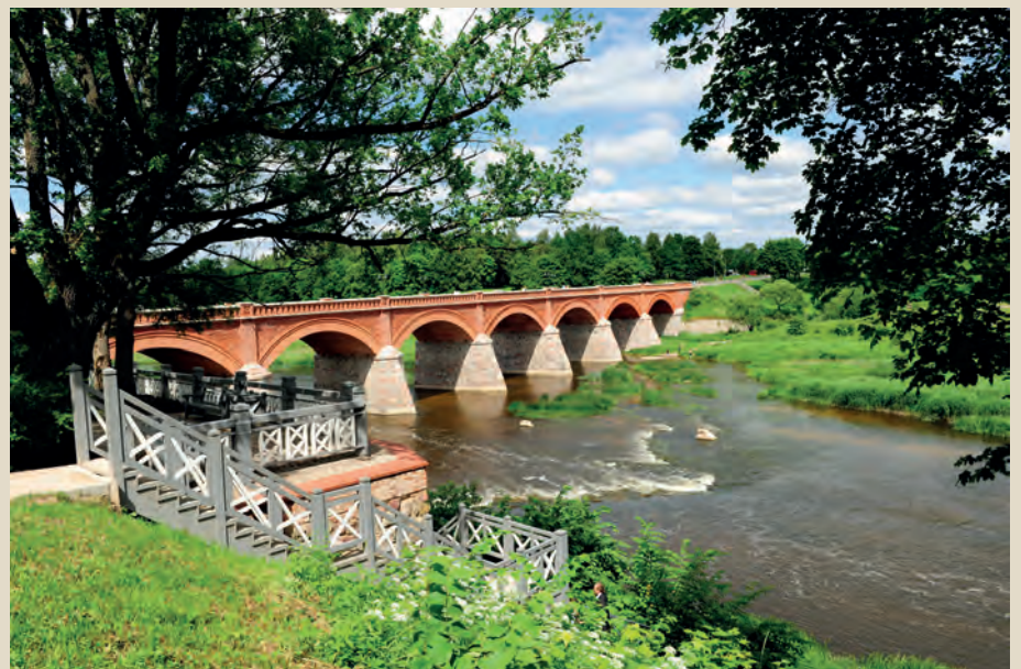
180. Mūra tilts pār Ventu Kuldīgā (A. Biedriņa foto. 2011) The masonry bridge across the Venta in Kuldīga (Photo by A. Biedriņš. 2011)
