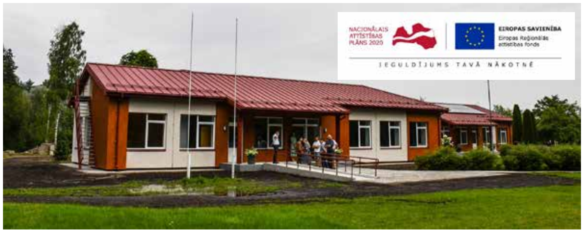
Noslēgsies Rumbas pagasta pārvaldes ēkas pārbūve, kuras laikā tika uzlabota energoefektivitāte. Septembrī ēkā atgriezies pagasta pārvaldes un bibliotēkas darbinieki.
