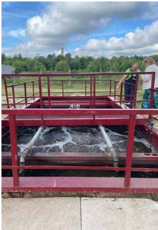
SIA "KULDĪGA ŪDENS" darbinieki atjaunojuši un modernizējuši notekūdeņu attīrīšanas staciju Laidu ciemā.
