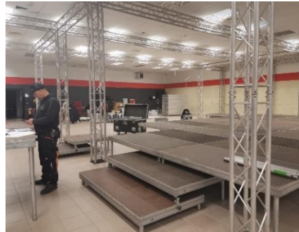
No pārvietojamām konstrukcijām top lielās zāles starpsiena un skatuve
