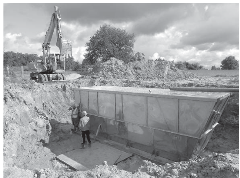
Snēpeles pagastā tiek ierīkotas jaunas notekūdeņu attīrīšanas iekārtas.
