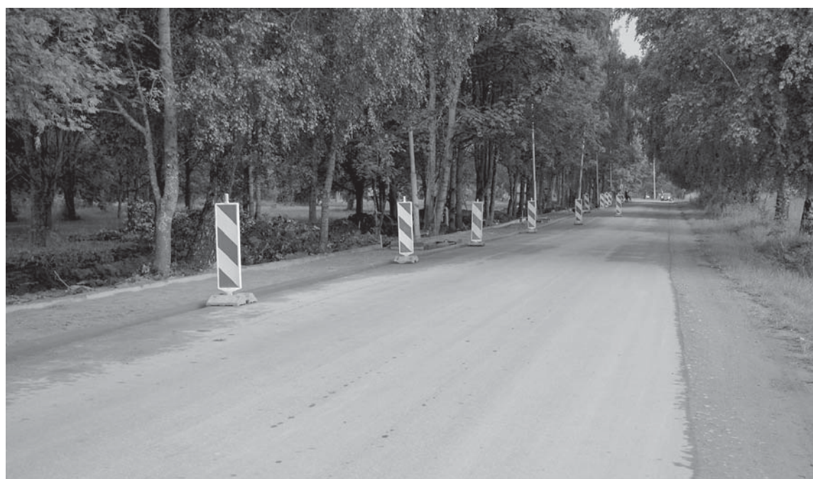
Krasta ielā pēc rekonstrukcijas būs vairāk nekā 20 jaunizveidotu autostāvvietu un jauni gājēju celiņi.
