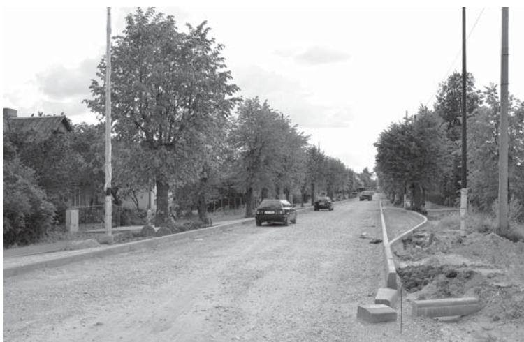
Stendes ielas rekonstrukcijā tiek pazemināta brauktuve, ieklāts jauns ielas segums, izveidotas gājēju ietves, velojoslas un autobusu pieturas, uzlabots ielas apgaismojums. Savukārt liepu aleja tiek papildināta ar jauniem dižstādiem.
