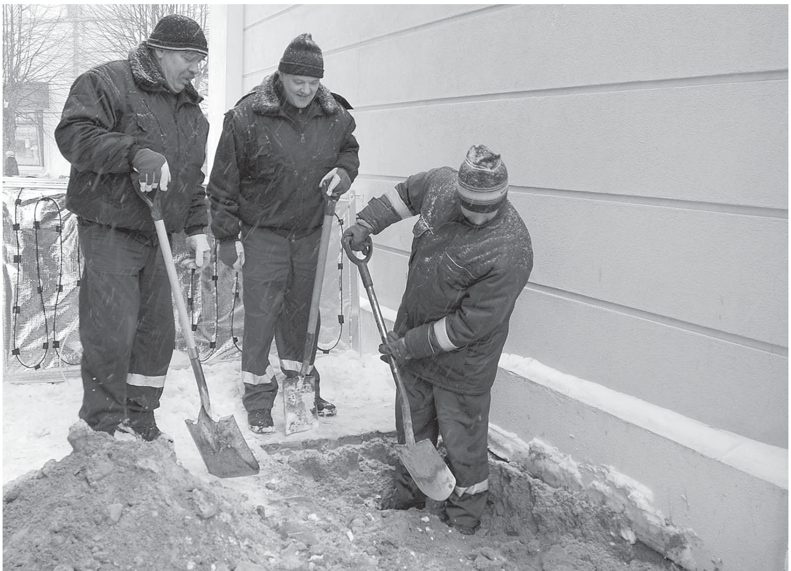
SIA „Kuldīgas ūdens” meistari Igors Mulda, Eduards Buks un Valdis Preiss Kuldīgas doktorātā atrok ūdensvada pievadu, kas bargās ziemas pārbaudījumu nav izturējis.
