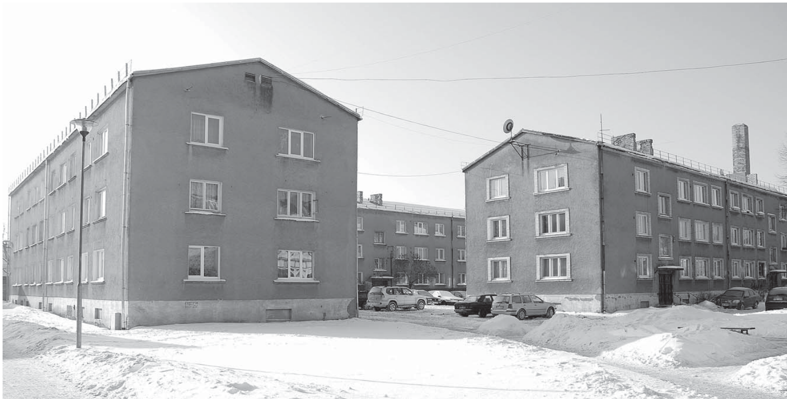
„Mājas ir jāsilina, lai samazinātu maksu par patērēto siltumenerģiju, citu variantu nav,” uzsver Kuldīgas novada Domes priekšsēdētājs 1. vietnieks Viktors Gotfridsons.
