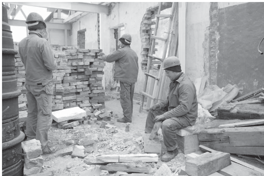
Depo ēkā izveidota pagaidu nojume (nams apvilts ar plēvi), kas pastāvīgi tiek apkurināta, lai varētu arī aukstajā laikā turpināt būvniecības darbus.
